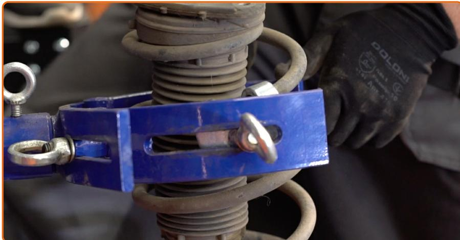
Limpe a haste do amortecedor. Use spray WD-40.
