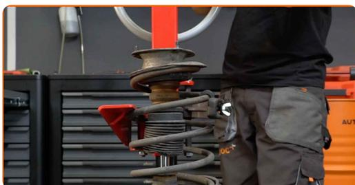
**21** Remova a tampa do apoio da coluna de suspensão. Utilize um pé-de-cabra.
